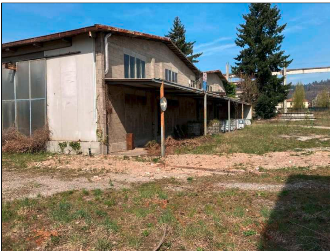
Fig. n. 3.5 – Edificio centrale adibito alla lavorazione dei manufatti.
