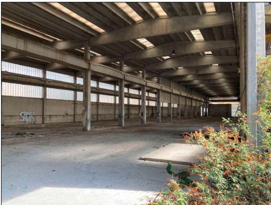
Fig. n. 3.3 – Capannone settentrionale adibito alla lavorazione dei manufatti.
