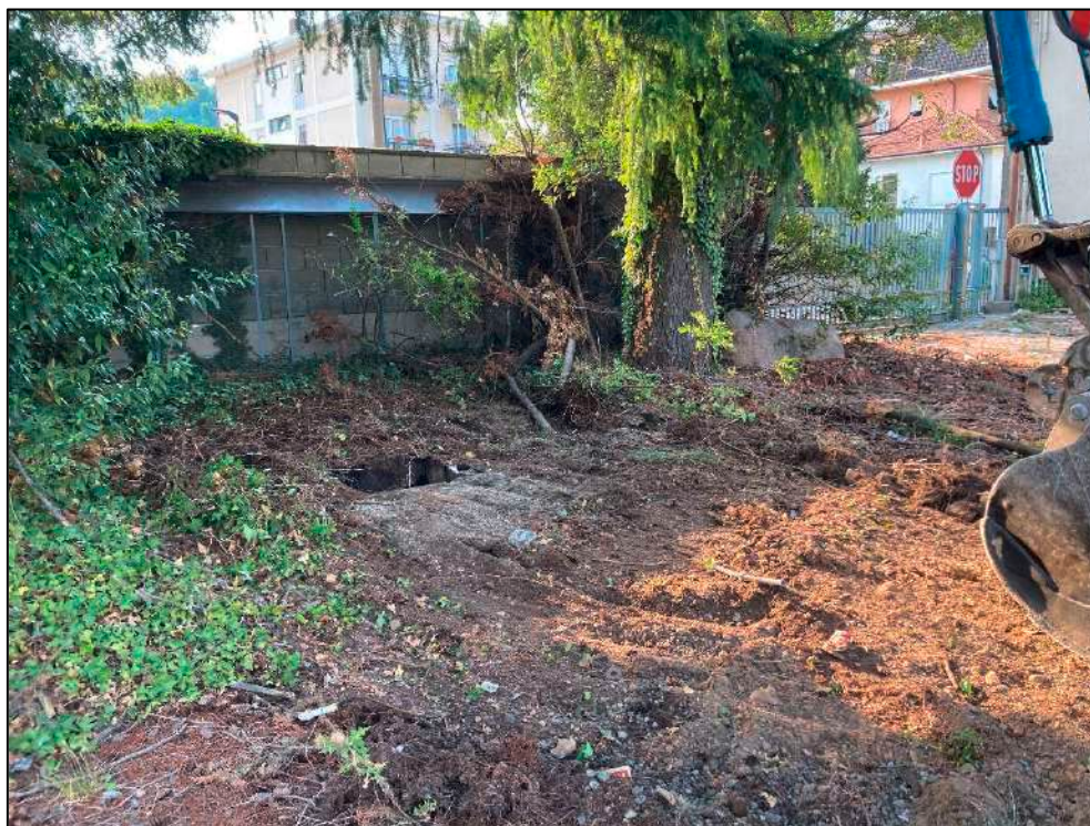
Fig. n. 3.6 – Serbatoio interrato.
