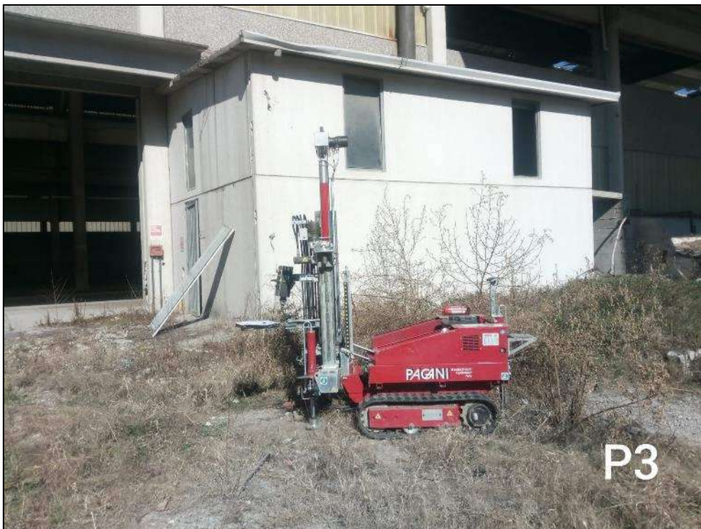
Postazione prova penetrometrica P3.
