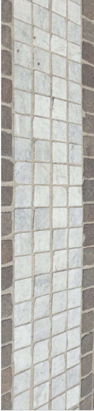
SCHEMA DI POSA PER DISEGNO ATTRAVERSAMENTI PEDONALI (CUBETTI BIANCHI)
