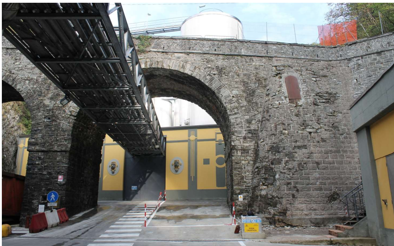
Foto 4 - Vista frontale da Sud dell'arcata Est.
