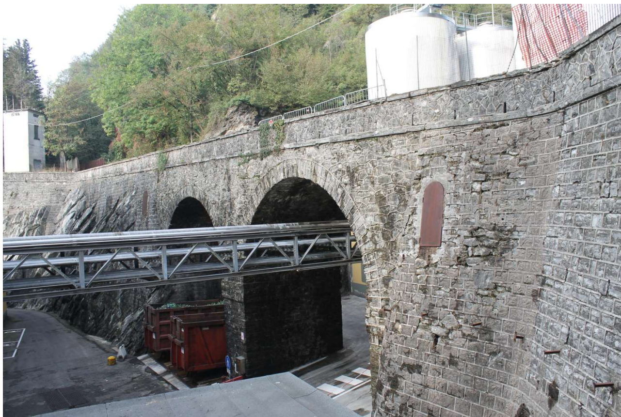
Foto 1 - Vista complessiva del manufatto dal lato Sud
