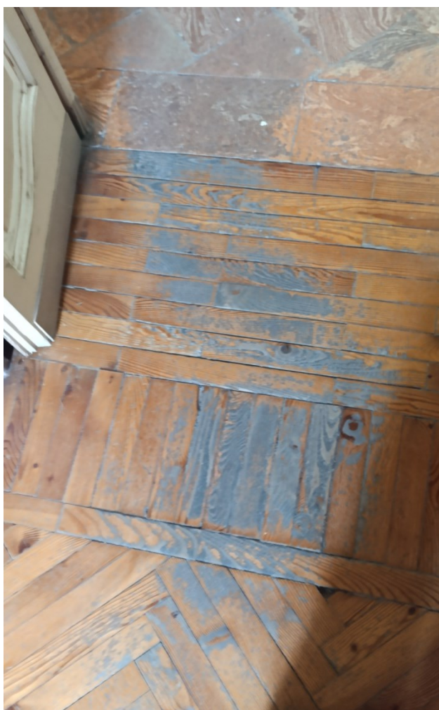
Sopra e sotto: dettaglio dei pavimenti in cotto e parquet del piano nobile della Villa con evidenti segni di usura e degrado che saranno oggetto di intervento con un'integrazione del progetto in fase esecutiva
