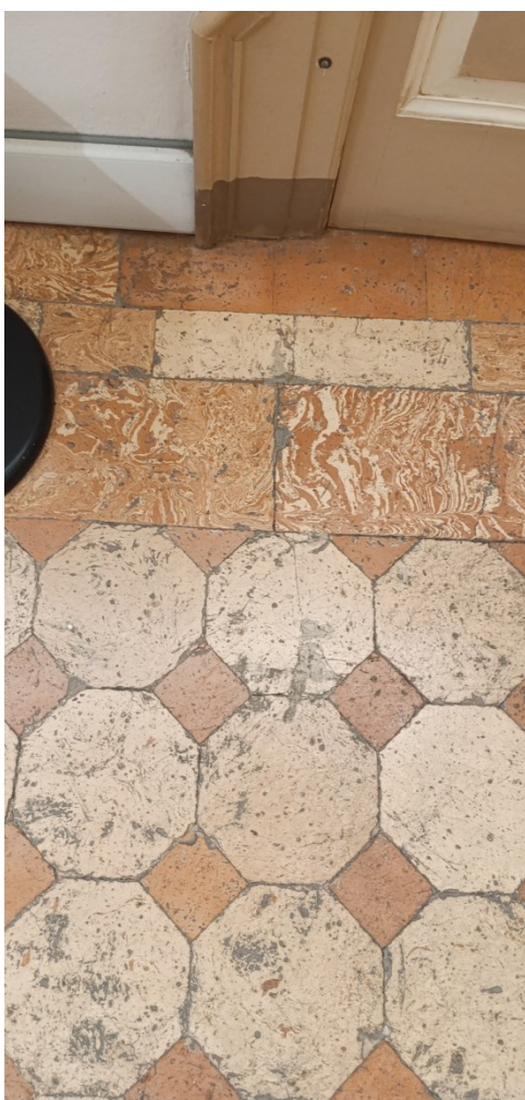
Sopra e sotto: dettaglio dei pavimenti in cotto e parquet del piano nobile della Villa con evidenti segni di usura e degrado che saranno oggetto di intervento con un'integrazione del progetto in fase esecutiva
