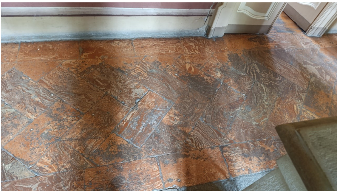
Sopra e sotto: dettaglio dei pavimenti in cotto e parquet del piano nobile della Villa con evidenti segni di usura e degrado che saranno oggetto di intervento con un'integrazione del progetto in fase esecutiva
