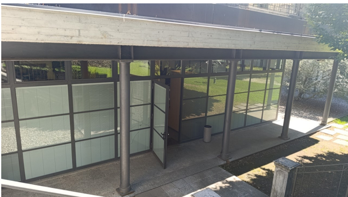
Sotto: vista di dettaglio delle pareti vetrate con antistante colonnato che caratterizzano il nuovo blocco
