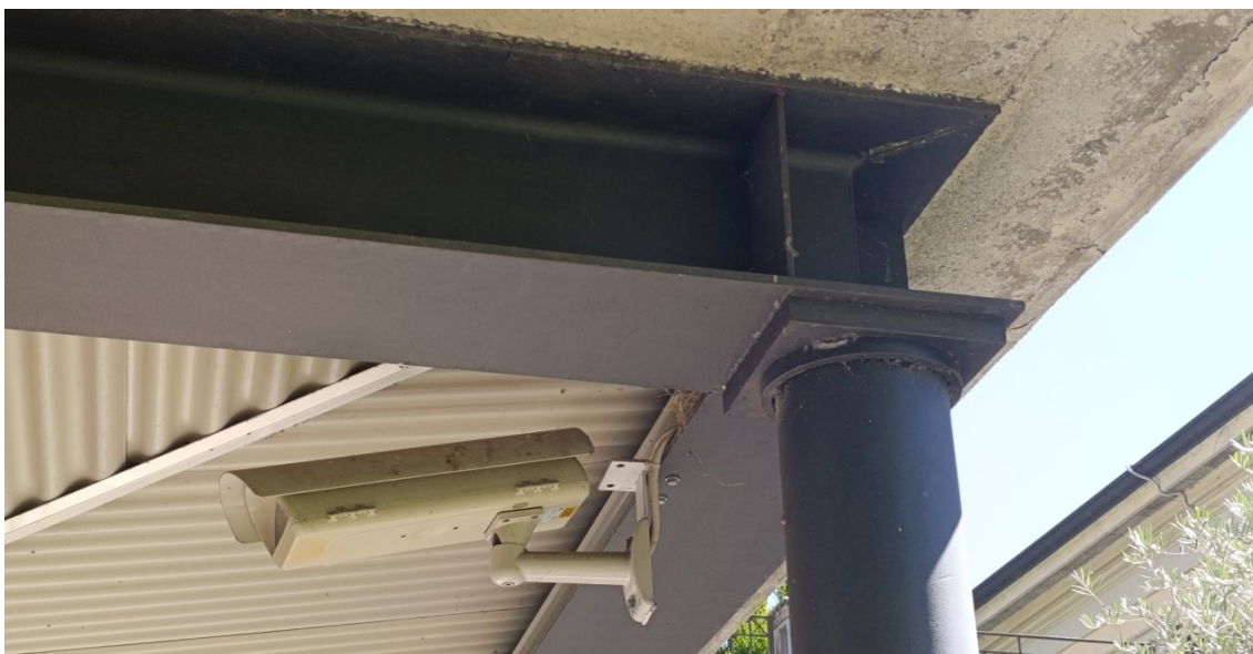
Dettaglio della struttura metallica che verrà conservata
