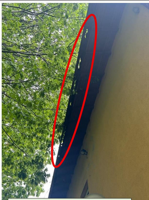
Deterioramento grondaia.
