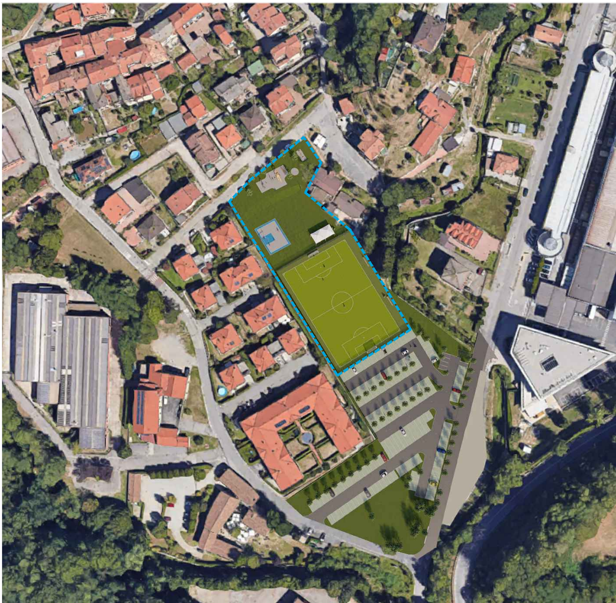
Vista aerea degli interventi
