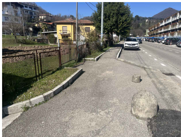
Ingresso 2 - Lato nord
