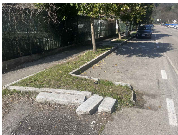
Ingresso 4 - Lato nord
