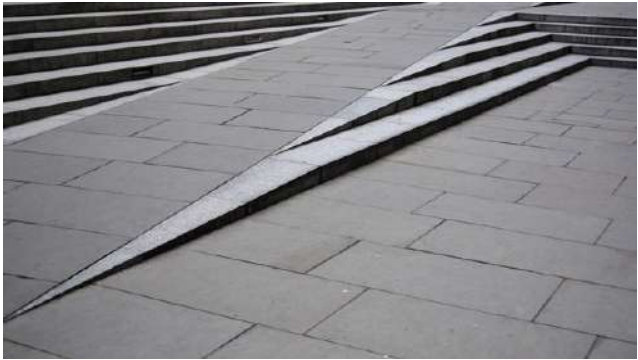
Scale e rampe
