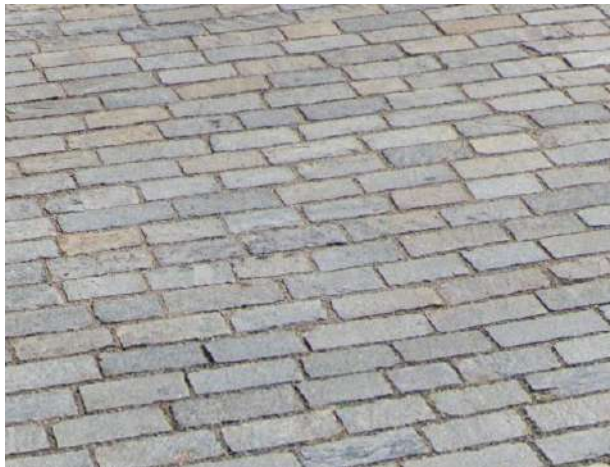
Pavimentazione in Luserna, posati a malta e boiaccia o resina, per le parti carrabili e strade
