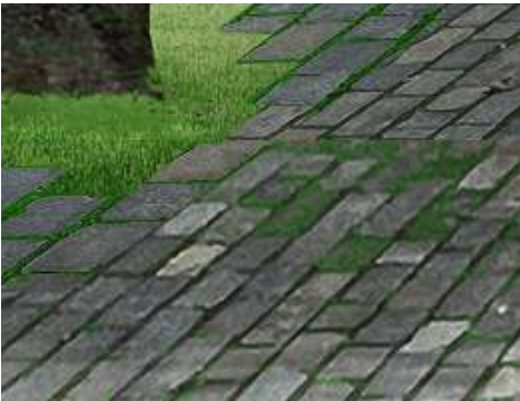
Pavimentazione in Luserna drenante, per le aree pedonali delle piazze
