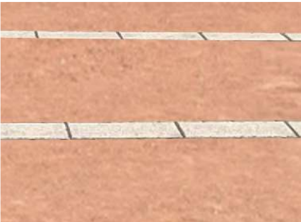
Pavimentazione in terra battuta per la Corte Riva
