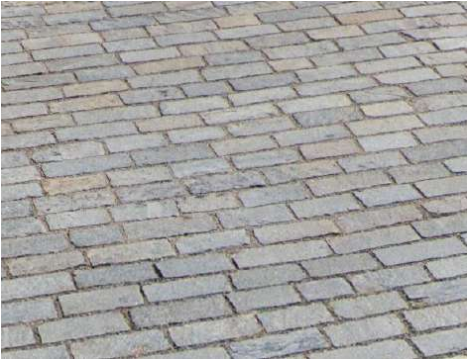
Pavimentazione in Luserna
