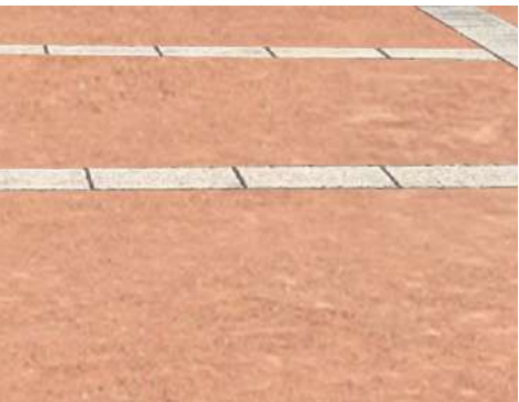
Pavimentazione in terra battuta per la Corte Riva
