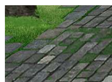
Pavimentazione in Luserna drenante, per le aree pedonali delle piazze
