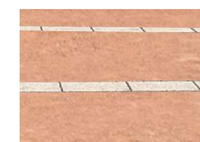
Pavimentazione in terra battuta per la Corte Riva
