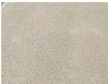
Pavimentazione in cemento drenante, per i corselli dei parcheggi
