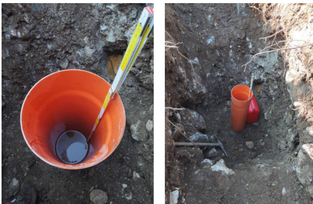
Figura 2 Scavo e anello per l'esecuzione della prova di permeabilità a -2 m
