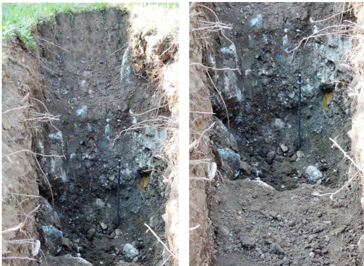
Figura 3 Scavo per l'esecuzione della prova di permeabilità
