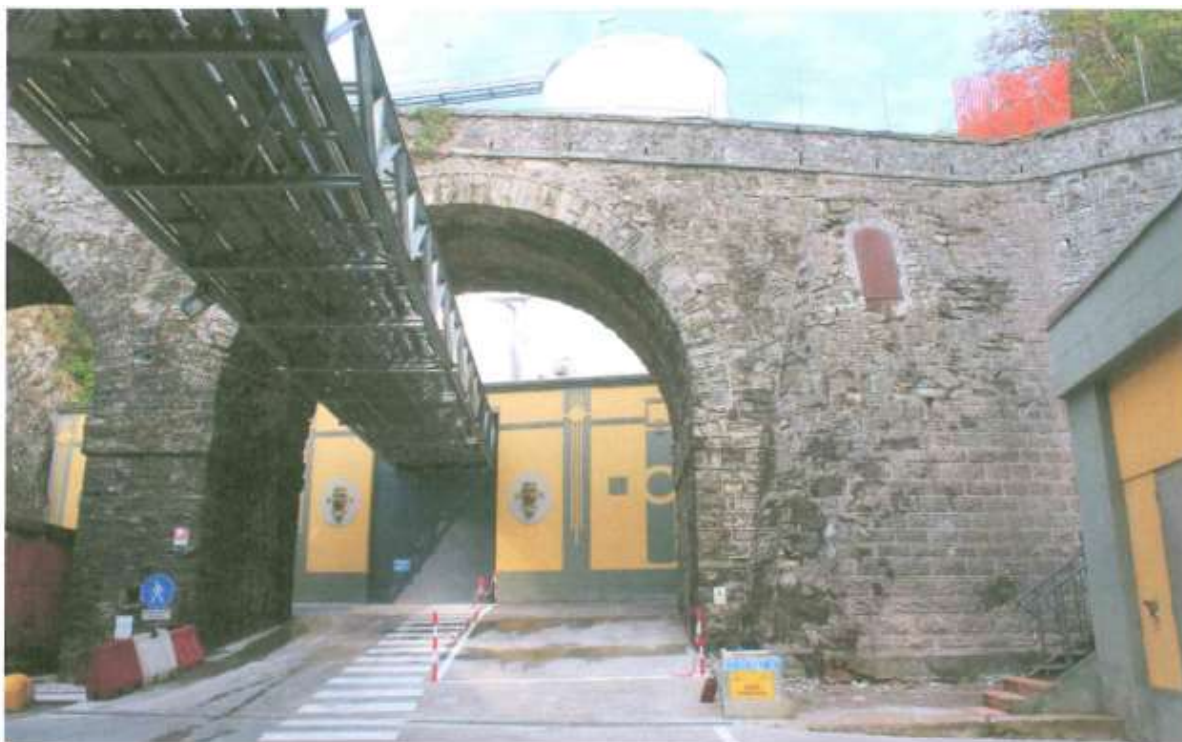
Foto 4 - Vista frontale da Sud dell'arcata Est.
