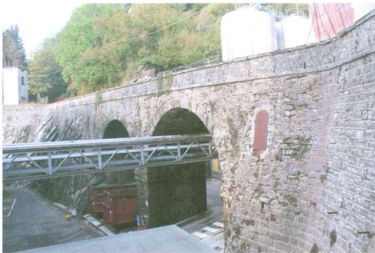
Foto 1 - Vista complessiva del manufatto dal lato Sud
