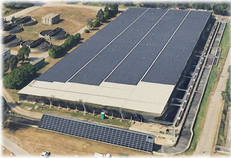
Foto area dell'impianto di Lonate Pozzolo post-intervento
