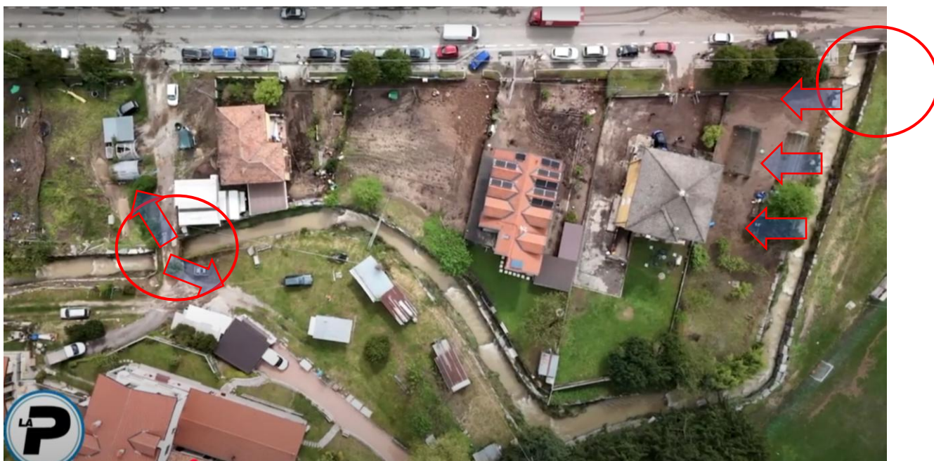
Attraversamenti critici e punti di esondazione dall'alveo
