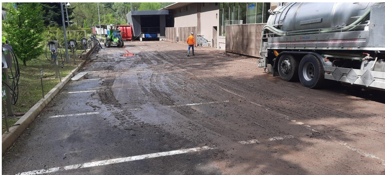
Piazzale retro palazzina Sud Lindt S.p.a. a seguito dell'evento del 23.04.2025
