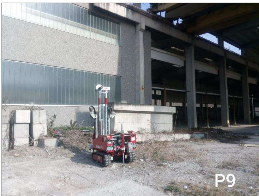
Postazione prova penetrometrica P9.
