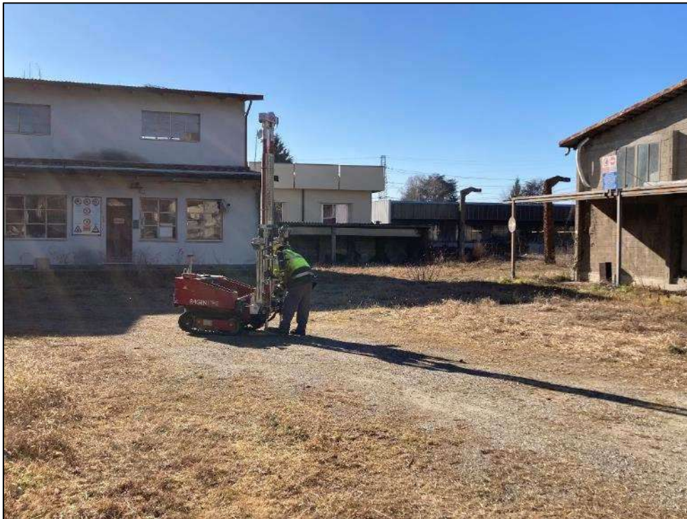
Postazione prova penetrometrica P1.
