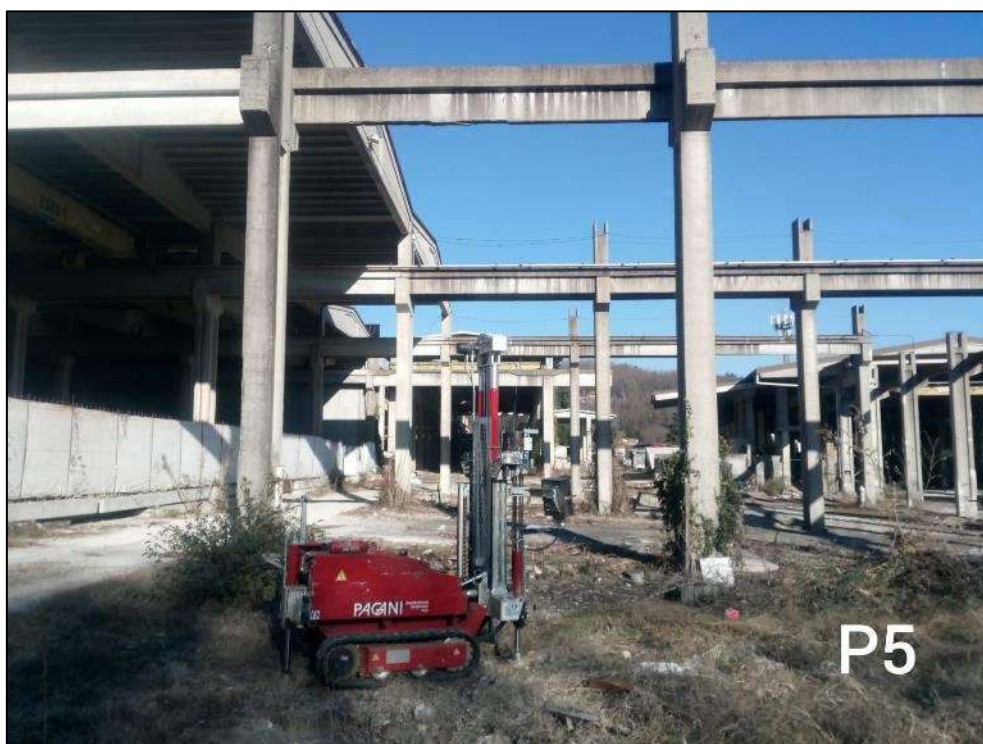
Postazione prova penetrometrica P5.
